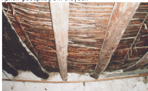
χρήση καλαμωτής στη στέγαση
