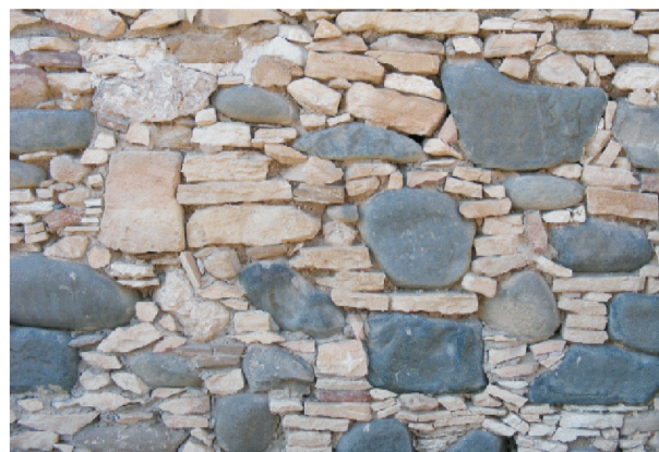
αργολιθοδομή από κροκάλες και ασβεστολιθικά πετρώματα πλινθοδομή
