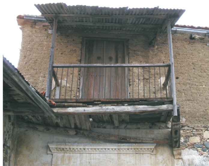
παραδοσιακοί εξώστες με μεταλλικούς ράβδους στο κιγκλιδώμα
