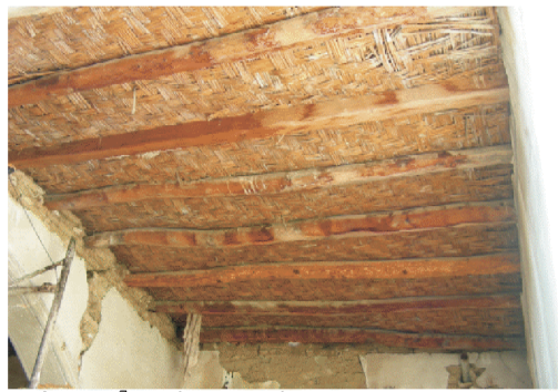
χρήση ψαθαρκάς στη στέγαση
